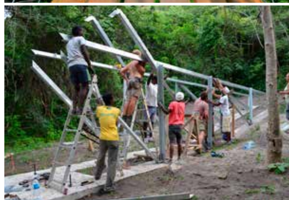
Mzamba bridge, South Africa Architectes : Université de sciences appliquées La Carinthie Ingénieurs Dr. Lühinger + Meyer Bauingenieure © bridgingMZAMBA
