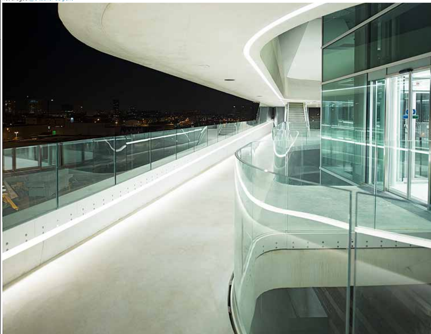
het brugdek_le tablier du pont
