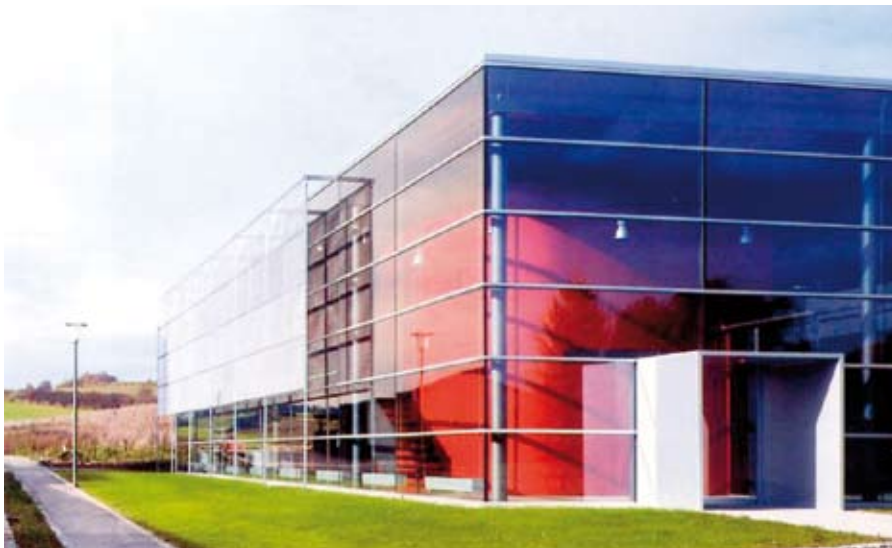
Afb. 4.14 Industriegebouw met gevel van structural glazing. Bron: Bauen mit Stahl e.V.
