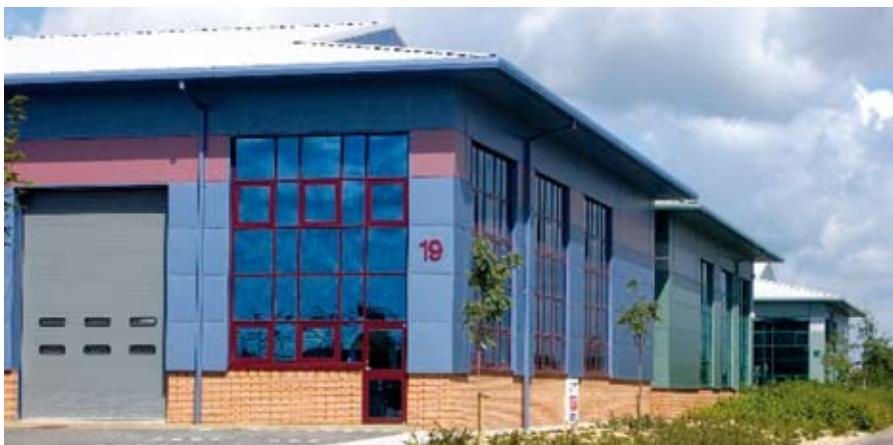
Afb. 4.11 Grote ramen in sandwichpanelen.
