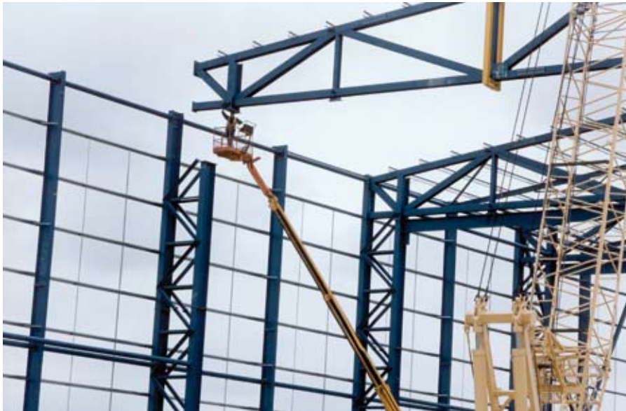
Afb. 2.13 Vakwerkligger met vakwerkkolom.
