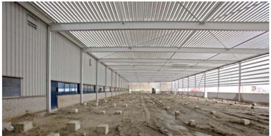
Afb. 5.2 Bij overspanningen tot 25 m hebben walsprofielen de voorkeur.
