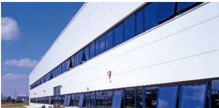
Afb. 4.10 Horizontale sandwichpanelen en strookramen.
