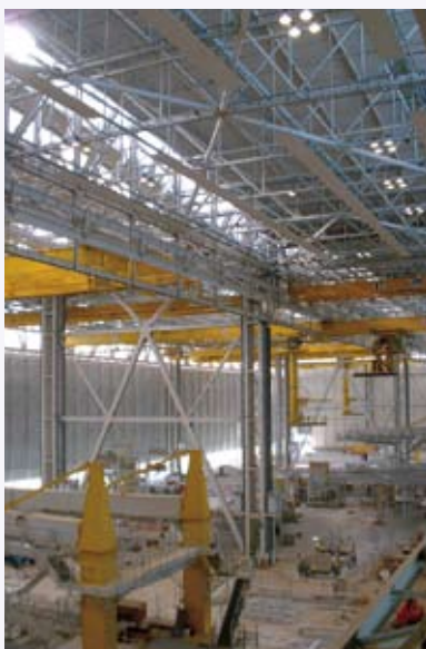
Interieur tijdens bouw.
