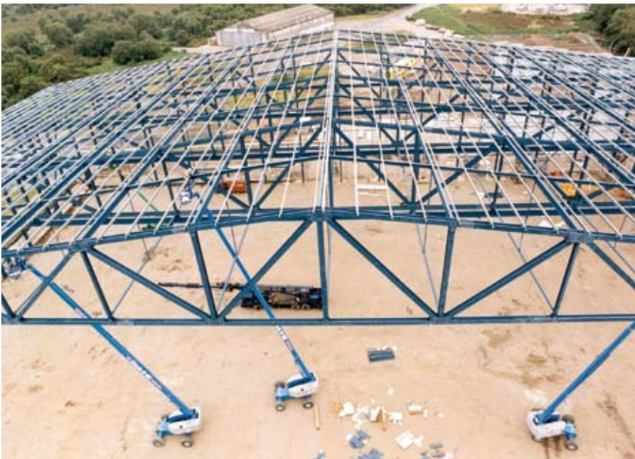
Afb. 2.11 (Boven) Verschillende typen vakwerklijgers gebruikt in industriegebouwen.
