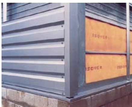
Afb. 5.5 Buitenbeplating op stalen binnendozen.
