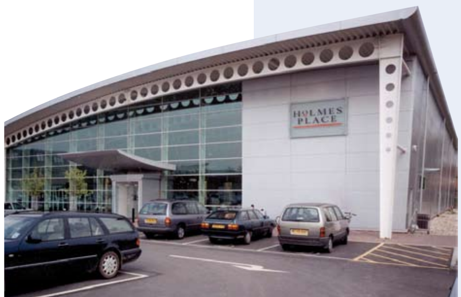
Afb. 1.1 Sport- en recreatiecentrum met een stalen draagconstructie.
