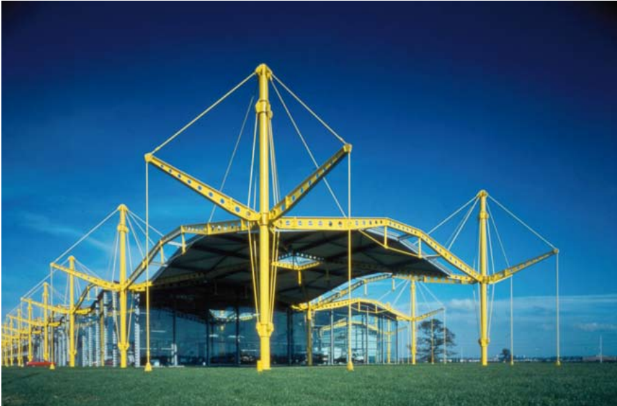
Afb. 2.14 Hangconstructie gebruikt bij de Renaultfabriek, Swindon, Verenigd Koninkrijk, gebouwd in de jaren '80.
