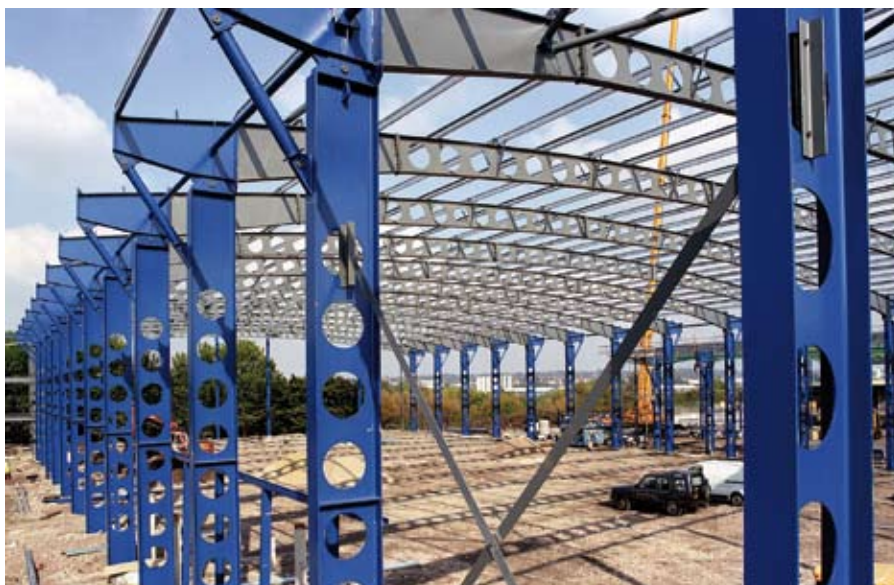
Afb. 2.9 Momentvaste verbindingen in een industriegebouw.
