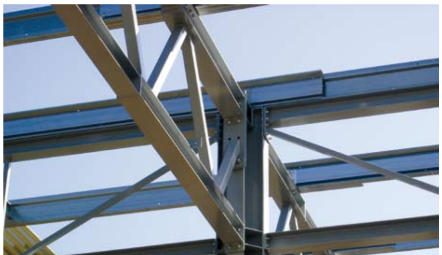
Afb. 5.3 Bij overspanningen groter dan 25 m zijn vakwerkliggers populair.
