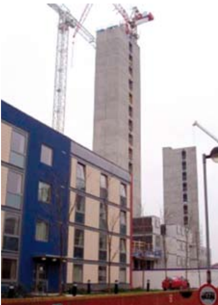
Afb. 9.1 Modules bevestigd aan de betonkern.
