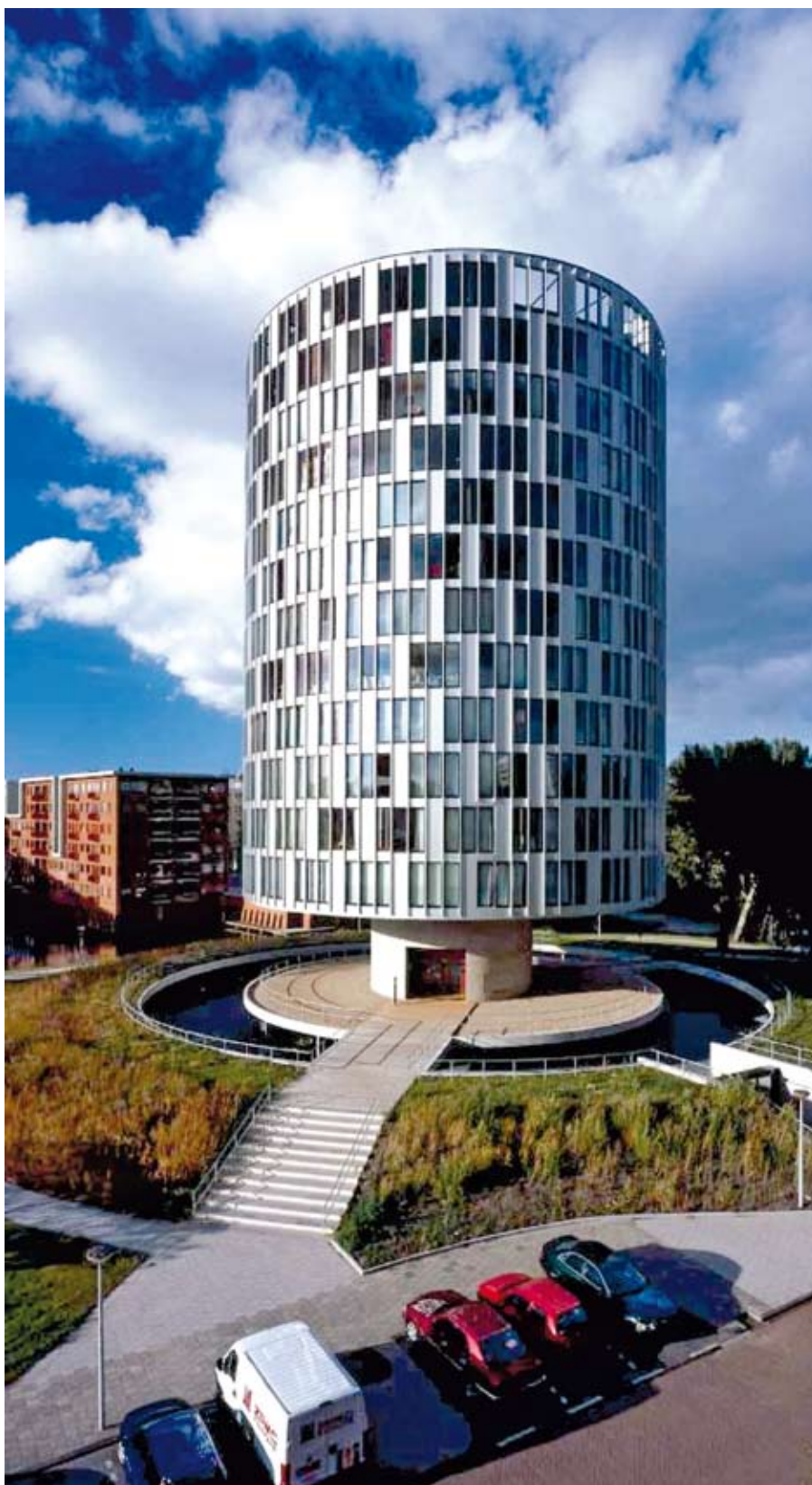
Afb. 8.7 Woongebouw met een staalskelet en staalplaat-betenvloeren: Schutterstoren in Amsterdam.
