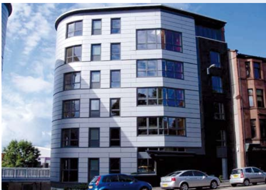
Afb. 7.1 Woongebouw van staalframebouw met metalen gevelbekleding in Glasgow. Bron: Peck and Reid Architects & Metsec.
