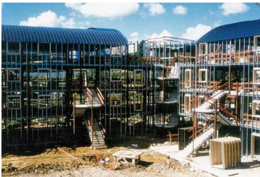
Afb. 8.10 PRISM-systeem tijdens de bouw. Staalskelet, dakplaat en staalframe binnenspouwbladen zijn zichtbaar. Daarop is de dak- en gevelbekleding nog te monteren.
