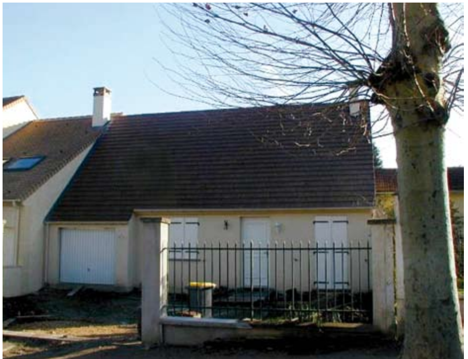
Afb. 8.14 Maison Phénix in aanbouw, met dakdetails voor een woning met één laag.
