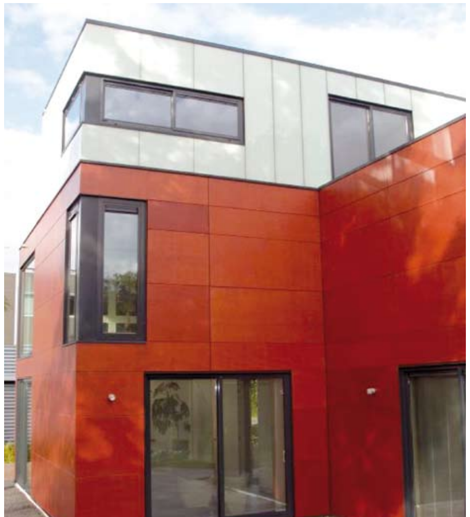
Afb. 8.9 (Boven en rechts) Staalskelet met kokerprofielen, metal-stud wanden en staalframevloeren: Smart House in Rotterdam.
