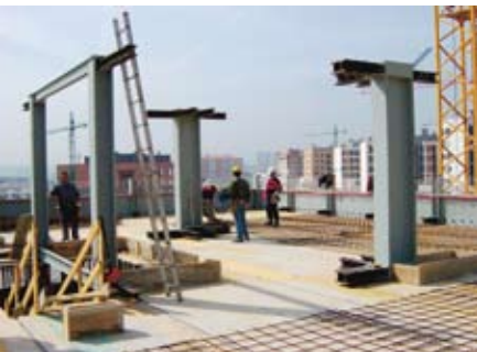
Afb. 9.11 Vloer met inwendige kolommen tijdens de bouw.
