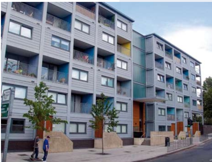
Afb. 6.1 Woongebouw in Londen met zelfdragende modules waarin balkons zijn geïntegreerd. Bron: AHMA Architects & Yorkon.
