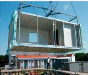
Afb. 9.13 OpenHouse-module tijdens montage. De module heeft open zijden en tijdelijke ondersteuning.
