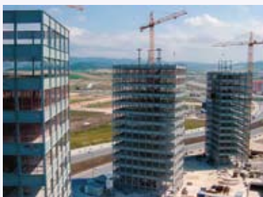
Afb. 9.7 Bioklimatische torens in aanbouw.
