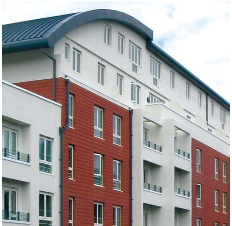
Afb. 7.2 Pleisterlaag op harde isolatie gecombineerd met keramische tegels bevestigd aan staalframe binnenspouwbladen.
