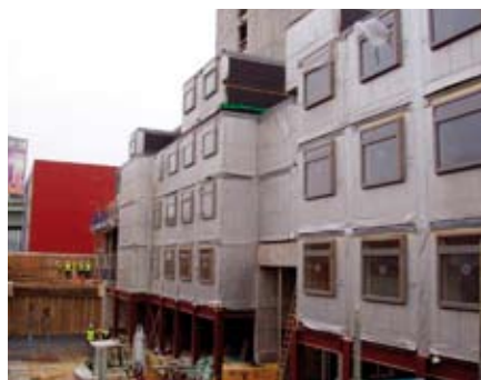
Afb. 9.2 Plaatsing van modules op podium.
