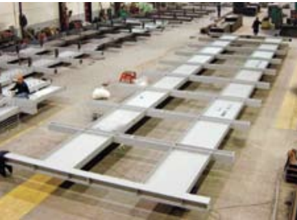
Afb. 9.10 Prefabricage van de gevelpanelen.
