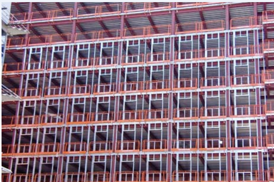
Afb. 4.4 Staalframe binnenspouwbladen in een staal-beton constructie.
