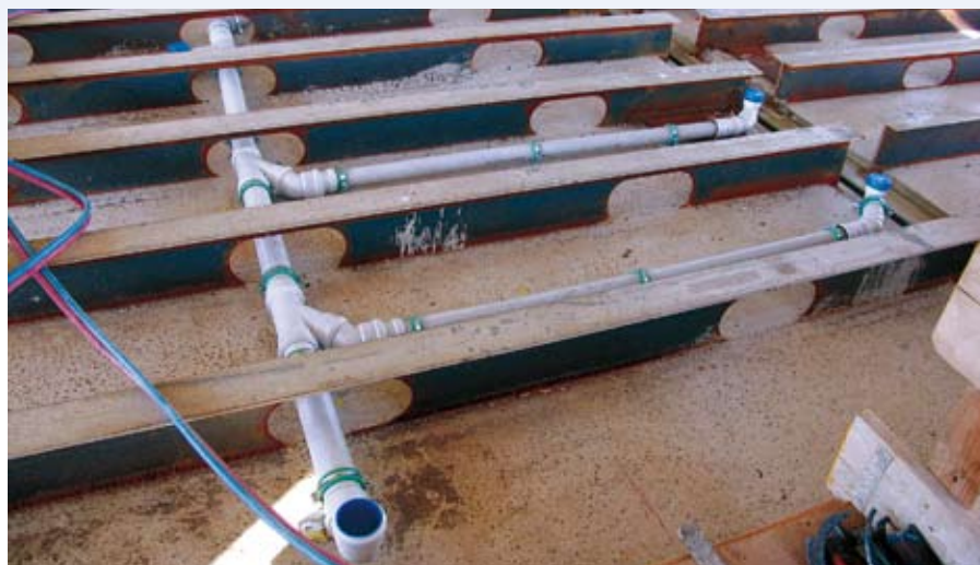
Afb. 5.5 Holle staal-beton vloer (Slimline).
