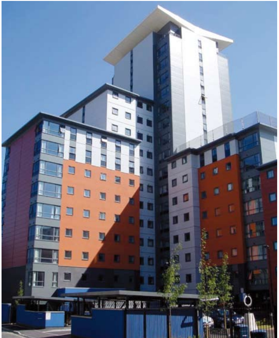
Afb. 2.2 Studentencomplex van 16 lagen met een staalskelet en lichte stalen prefab wanden in Southampton, Verenigd Koninkrijk.
