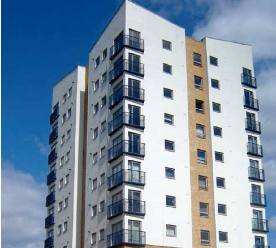
Afb. 8.2 Woningbouw met modules in in Basingstoke, Verenigd Koninkrijk. Bron: PRP Architects & Vision.
