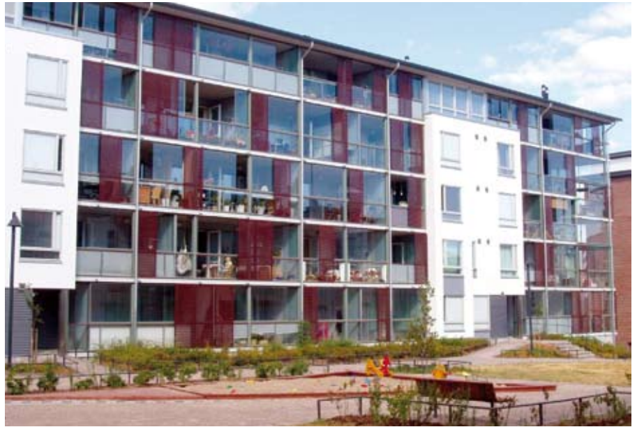
Afb. 2.1 Appartementenbouw in Helsinki met balkons die onderdeel zijn van het staalskelet. Architect: Kahri Architecten.
