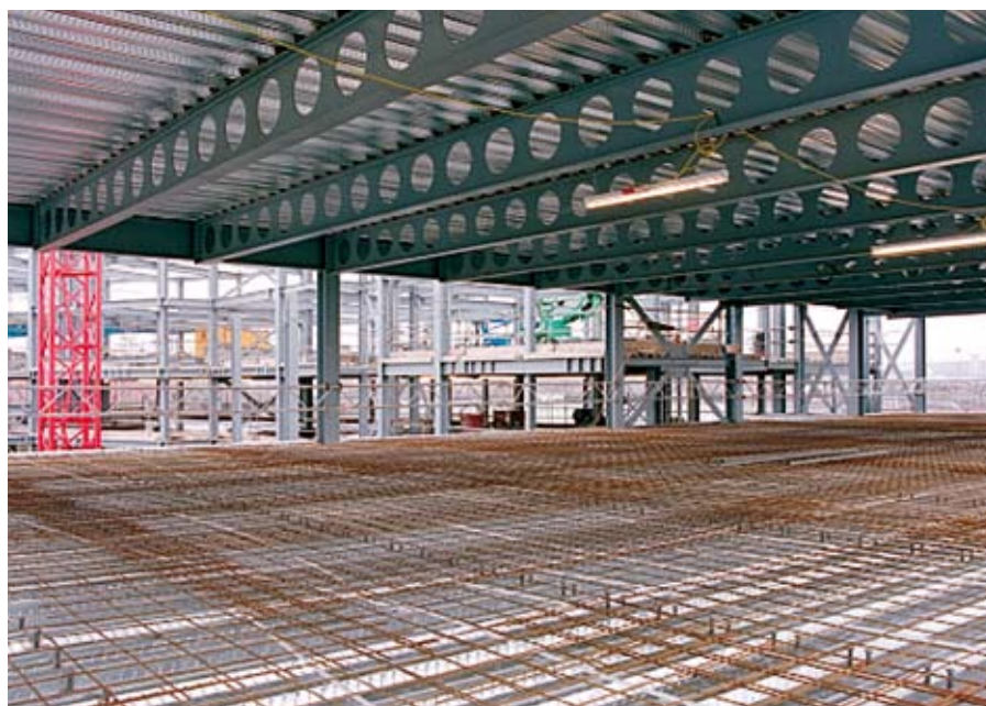
Afb. 5.3 Staalplaat-betonvloeren opgelegd op staal-beton patrijspoortliggers.
