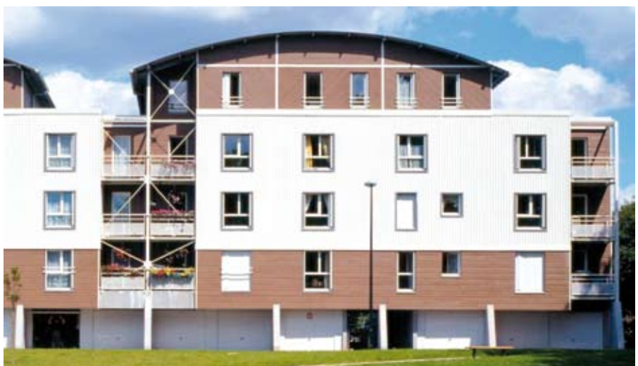
Afb. 2.3 Appartementengebouw met staalskelet in Evreux, Frankrijk, met staalframe wanden en vloeren en lichtgewicht gevelbeplating. Architect: Dubosc & Landowski.
