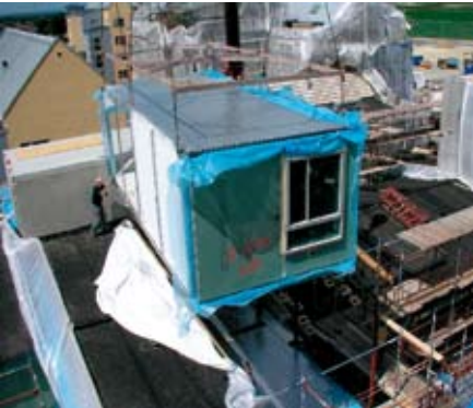
Afb. 9.14 (Boven) Montage van module op de bouwplaats aangevoerd met binnenspouwblad, folies en kozijnen.
