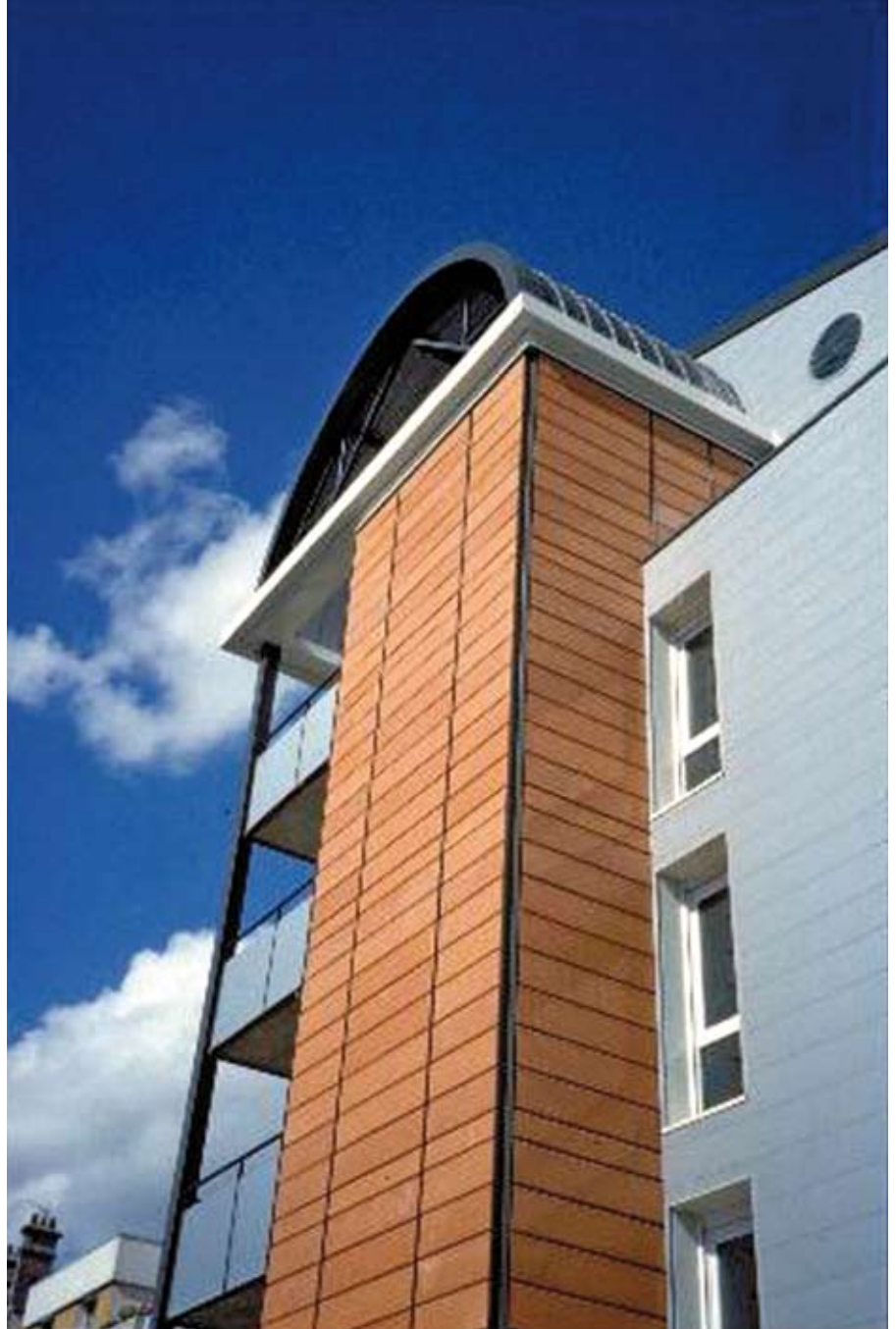
Afb. 8.12 PRISM-systeem: gebouw met verschillende gevelbekledingen.
