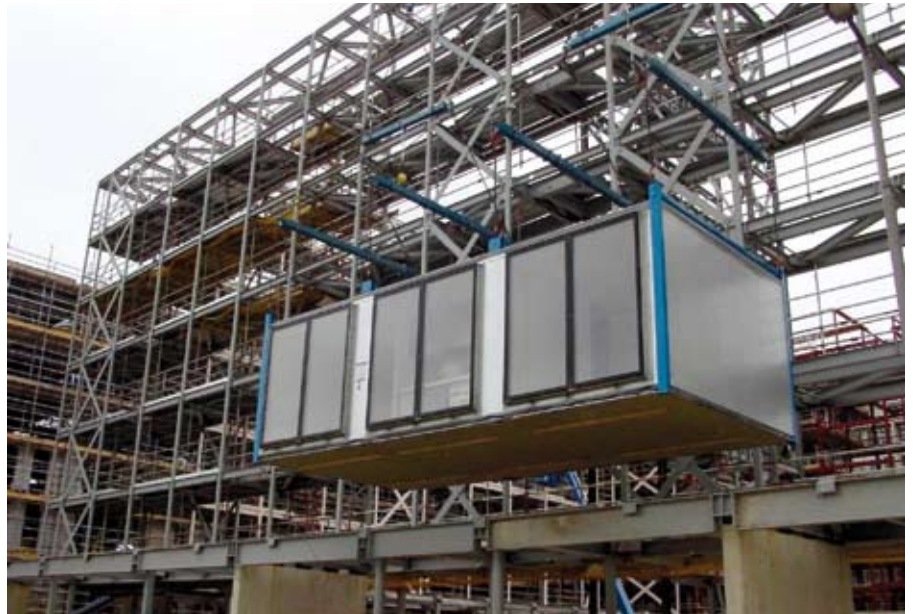
Afb. 8.3 Staalskelet met modules met een groot raamoppervlak: MOHO in Manchester. Bron: Yorkon and Shed KM Architects.
