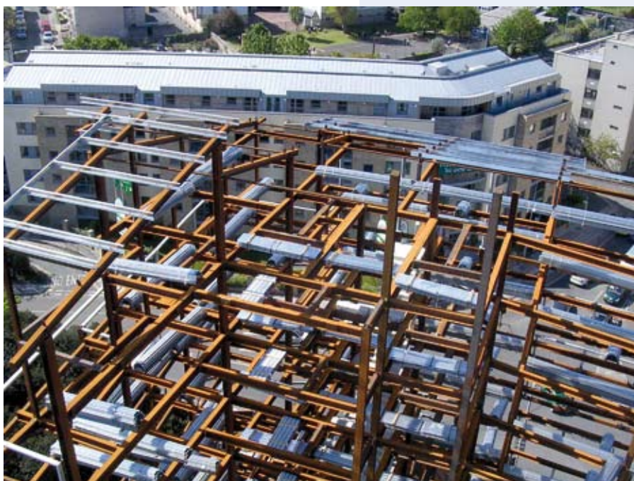
Afb. 5.1 Staalskelet met ASB-liggers tijdens de montage van hoge staalplaat-betonvloeren.
