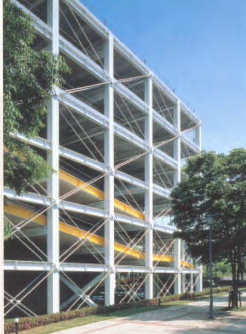
Moderne brandveiligheidsconcepten bieden een hoge ontwerpvrijheid. Een staalconstructie kan onbeschermd blijven in grote open ruimten met een geringe vuurbelasting, zoals in parkeergarages met open gevels en in atria.
