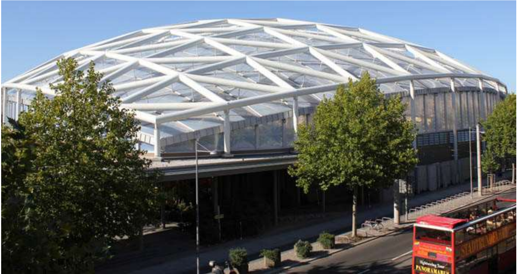
Tropenhalle im Zoo Leipzig Spannweite 154 m
